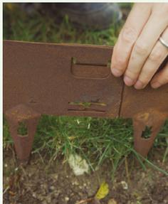
Après avoir fixé la bordure en haut, prenez une paire de pinces et pliez les languettes de verrouillage en bas pour fixer complètement les deux morceaux de CORE EDGE ensemble.
